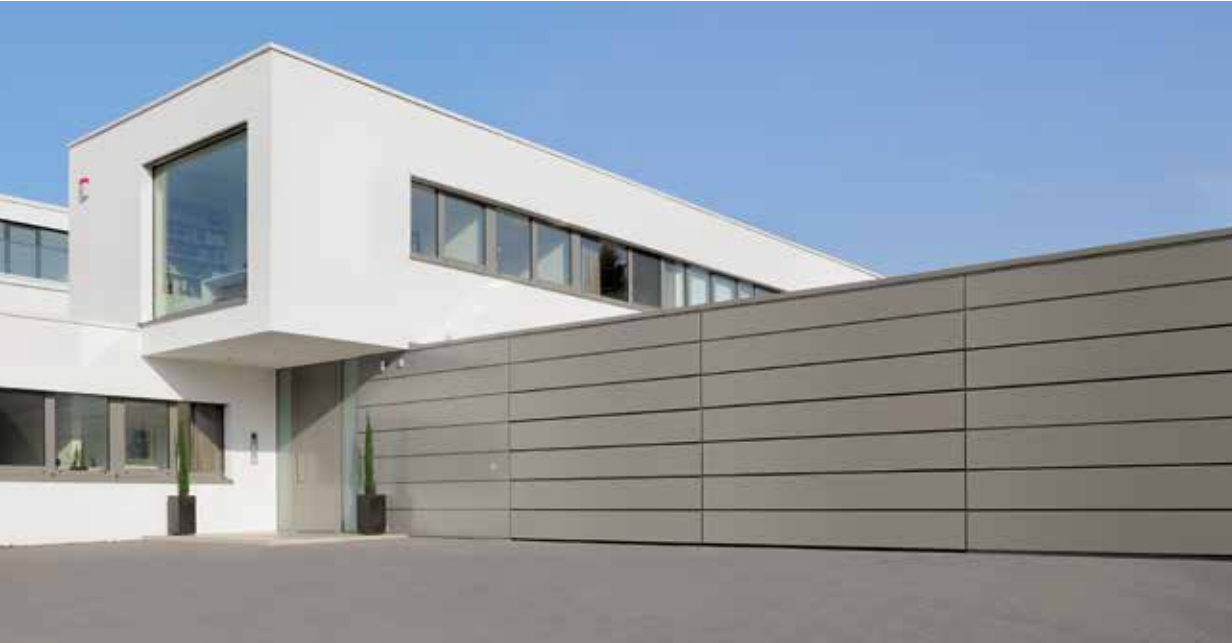
Oblaganje na mjestu postavljanja, s aluminijskim vezivnim pločama
