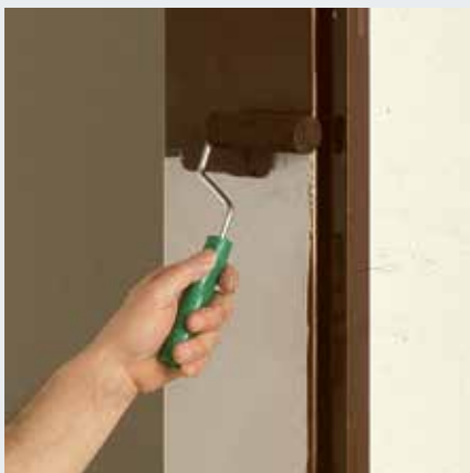
Gyárilag alapozott és porszórt acéltokok tetszés szerint átfesthetők.
